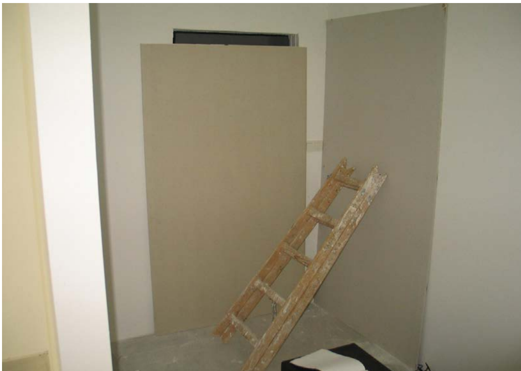
Fot. 2 Prowizoryczne zabezpieczenie otworu drzwiowego płytą GK podczas pomiarów izolacyjności akustycznej, ze względu na brak zamontowanej stolarki drzwiowej wewnątrz mieszkania
